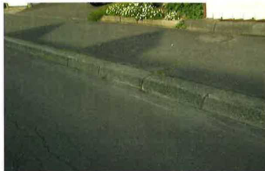
図10 寒冷地における振動締固め製品（AE製品） 境界ブロック 千歳市 経年10年 劣化度2
