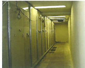
廊下片側に設けた仮囲いでの施工
