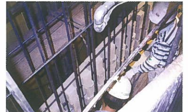
設備機器に挟まれた狭い施工
