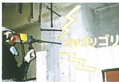
アンカー打設
