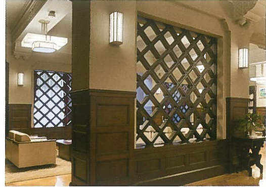
鑄鉄製ブロックによる新設壁
