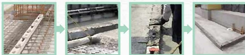
コンクリート打設の準備完了
