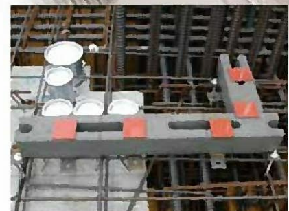
金物取付後のBJBブロック
