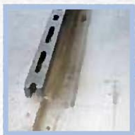
アンカー筋設置
