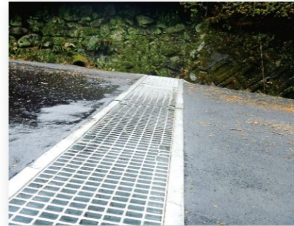
⑥ 舗装完成
