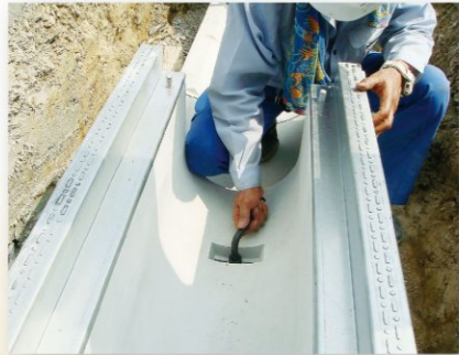
④ 固定ボルト締め
