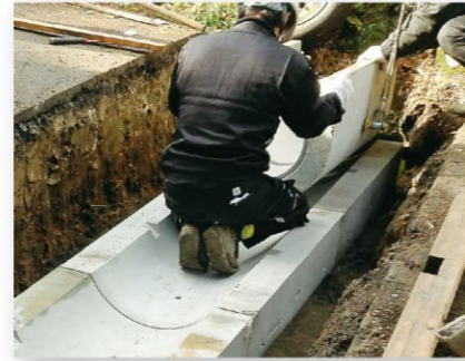
③ 側溝据え付け
