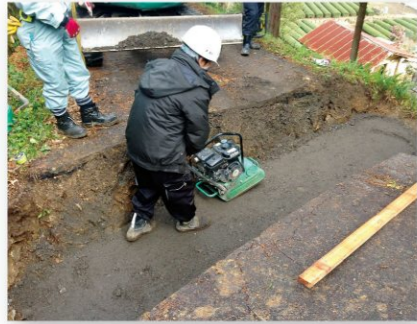
① 基礎材敷設
