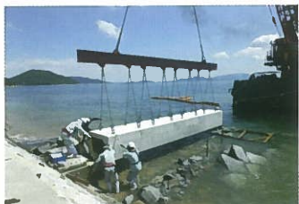
写真-2 香川県高松市女木町 ボックスカルバート 1000×600mm
