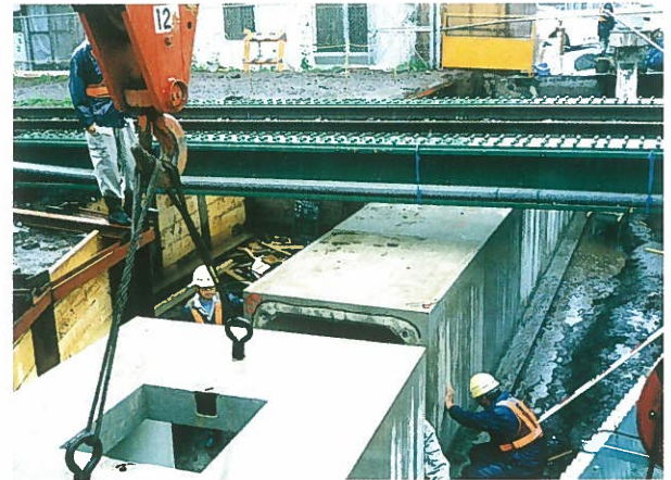
・軌道下での施工
