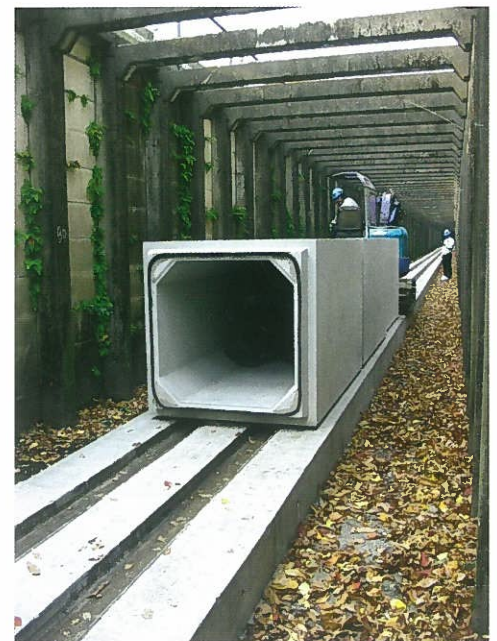
・クレーン車が使えない狭い場所での施工
