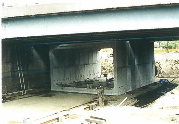
・橋梁下での施工
