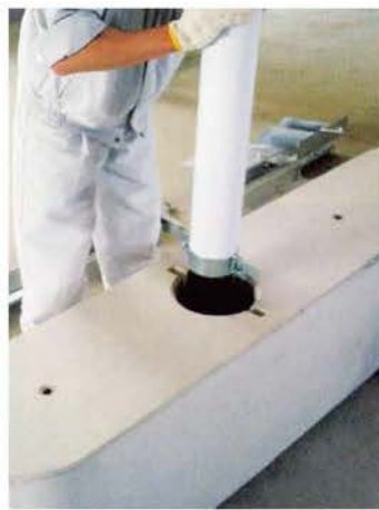
基礎に設けた切り込み溝に、やじろべえ金具を取り付けた支柱を建て込む。
