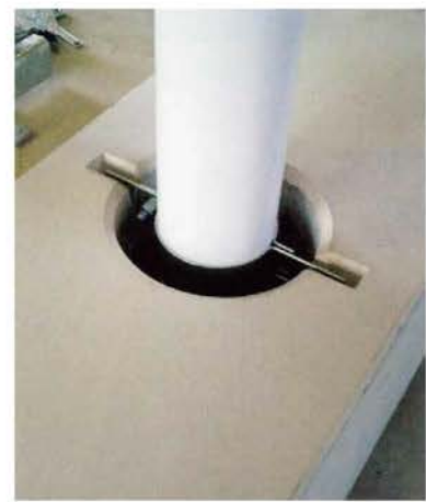
基礎に設けた切り込み溝に、やじろべえ金具を取り付けた支柱を建て込む。
