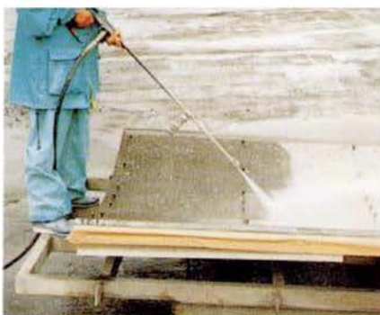
ウォータージェット洗浄による目荒し
