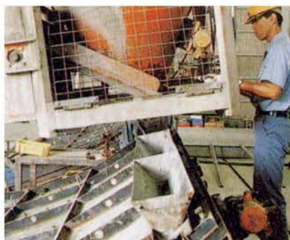
ファイバーモルタルの打設
