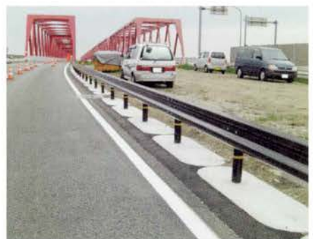
三重河川国道事務所 R23 (三重県)
