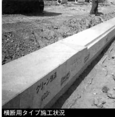
横断用タイプ施工状況
