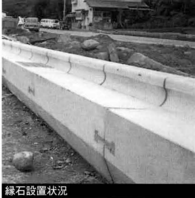
縁石設置状況
