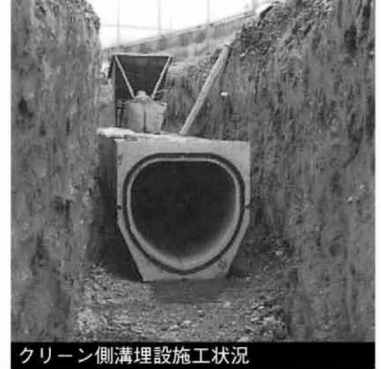
クリーン側溝埋設施工状況
