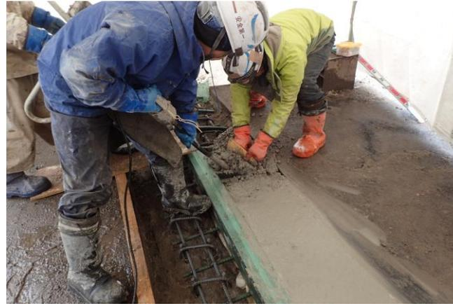
超速硬コンクリート打設
