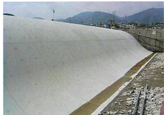
水路構造物への適用例(耐摩耗性、耐久性)
