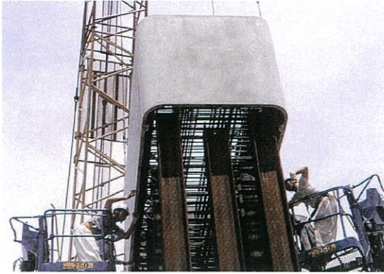
橋脚脚注への適用例(急速施工)
